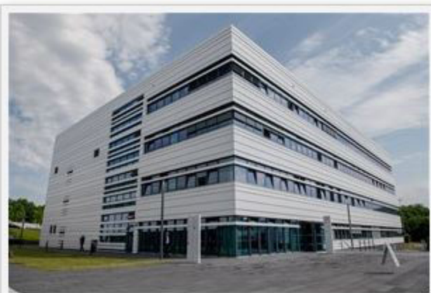
Der Forschungsbau ist im Zeit- und Kostenrahmen am Bochumer Gesundheitscampus errichtet worden. © RUB, Marquard
